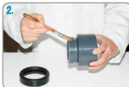
2. Lubrificar el relieve del accesorio donde irá encajada la junta.
