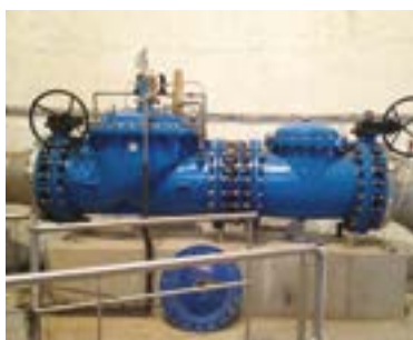
FILTRO CAZAPIEDRAS PARA PROTEGER UNA VÁLVULA HYDROBLOC
