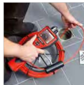
Inspección de sumideros
