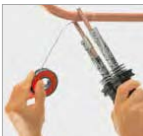
Calentamiento de la zona a soldar sin llama
