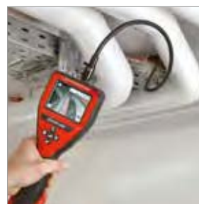
Inspección de espacios huecos
