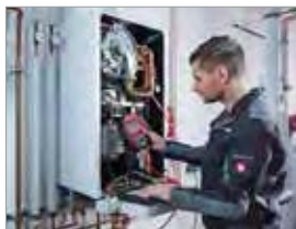
Comprobación de reguladores de presión de gas
